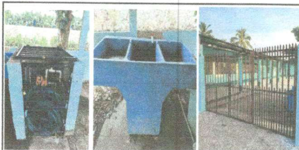
Foto 6: Limpieza y reparación de la Fosa Séptica
