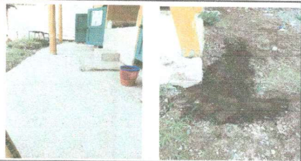
Foto 5: Sustitución de piso de torta de concreto
