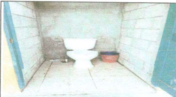
Foto 3: Reparación de la red de drenaje y limpieza de la fosa séptica, debido a que hay veces que el agua sale por debajo de los sanitarios
