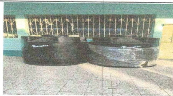
Foto 4: Sustitución de depósito de agua de 1700 litros
